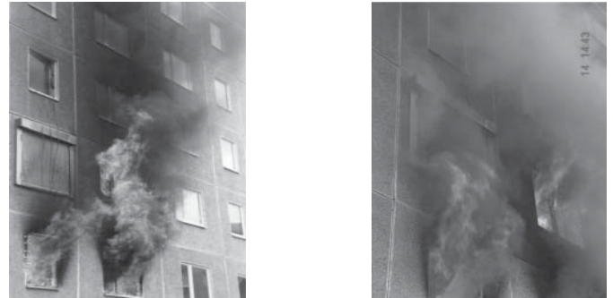
Abbildung 2: Nach 12 Minuten flash over in der ersten Etage, nach 20 Minuten flash over in der 2. Etage nach [7]
