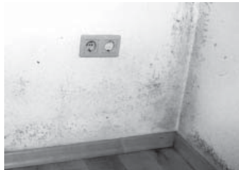
Abb 1: schimmelbefallene Außenwand, unterstes Geschoss
