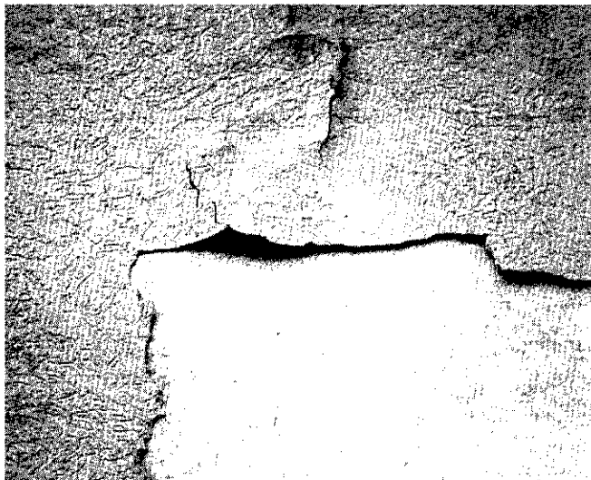
Bild 7: Flächenhafte Putzablösung
