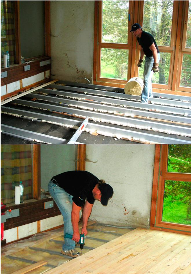
Hier übernimmt das Material Schaumglas die Funktionen: Feuchtigkeitsabdichtung, Wärmedämmung und Dampfsperre an der dem Raum zugekehrten, also warmen Seite.
