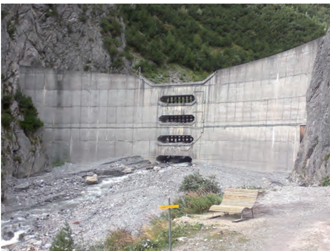
Abbildung 1: Gschiebbestausperre in einem Wildbach (Foto Sauermoser)
