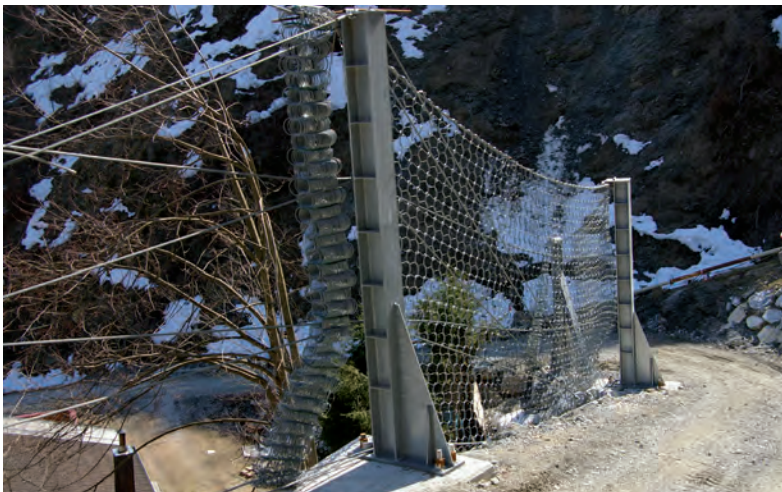
Abbildung 3: Errichtung eines Steinschlag-schutznetzes (Foto Sauer Moser)
