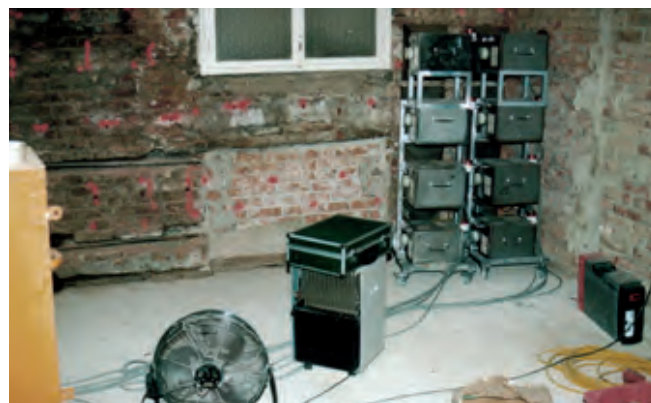
Abbildung 15: Mauerwerksentfeuchtung – Mikrowellentechnik (Quelle: Balak/Pech, Mauerwerkstrockenlegung 2 [2008])
