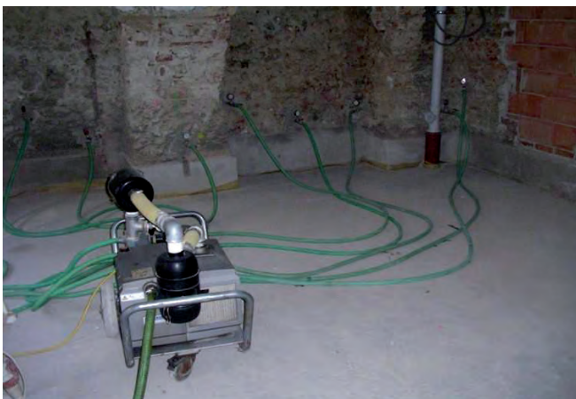
Abbildung 16: Mauerwerksentfeuchtung – Vakuumtechnik
