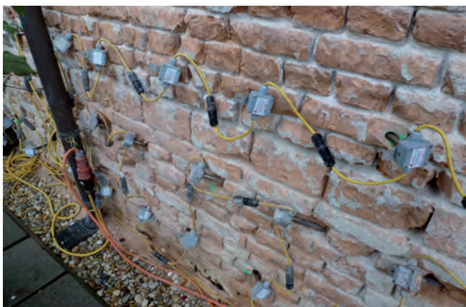
Abbildung 14: Mauerwerksentfeuchtung – Heizstabtechnik
