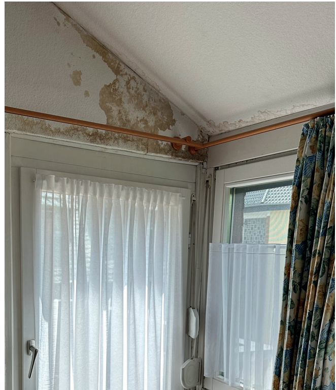
Abbildung 14: Feuchteschaden innen
