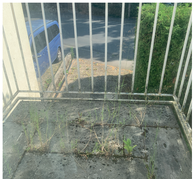
Abbildung 2: Bewuchs auf Balkonoberseite
