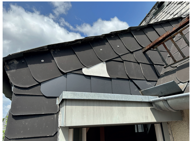
Abbildung 15: Defekte Dacheindeckung
