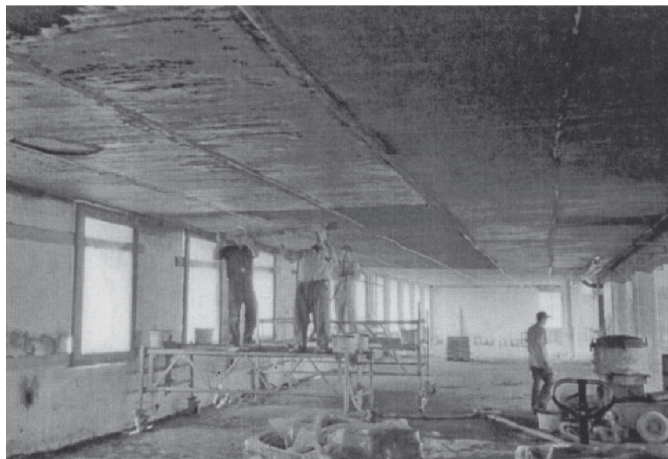
rechter Bildrand oben: unbehandelte Betonoberfläche rechter Bildrand mittleres Drittel unten: HDW-gestrahlte Betonoberfläche
